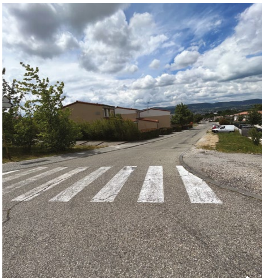
Fin des travaux prévus décembre 2023.
