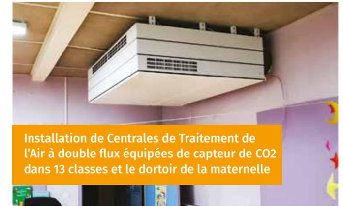
Installation de Centrales de Traitement de l'Air à double flux équipées de capteur de CO2 dans 13 classes et le dortoir de la maternelle
