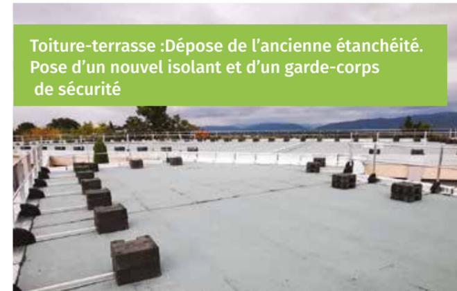
Toiture-terrasse :Dépose de l'ancienne étanchéité. Pose d'un nouvel isolant et d'un garde-corps de sécurité
