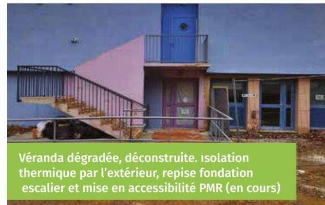
Véranda dégradée, déconstruite. Isolation thermique par l'extérieur, repise fondation escalier et mise en accessibilité PMR (en cours)
