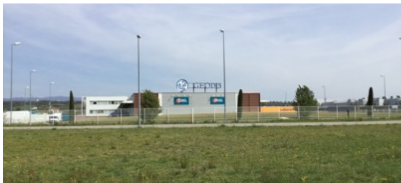
Enseigne sur toiture, Etoile-sur-Rhône, avril 2019
