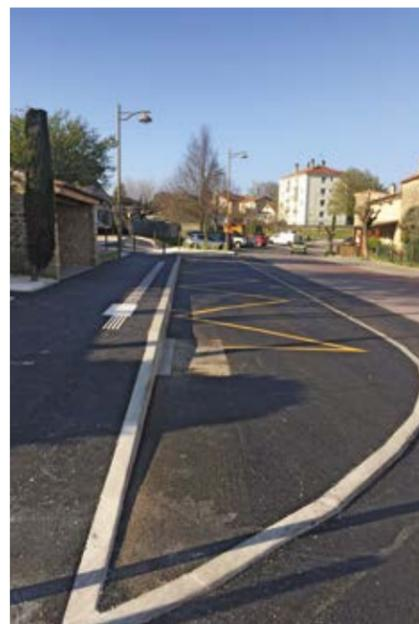
Sur le boulevard des remparts, le quai de l'arrêt du bus a été mis en accessibilité pour les personnes à mobilité réduite. La bordure du trottoir a donc été rehaussée pour que le marchepied du bus et le trottoir soient à la même hauteur.
