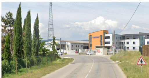
Vues sur l'entrée principale de la zone d'activités
