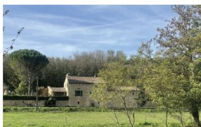
Ferme «élaborée» : murs en moellons et gros blocs d'angle, chaînage d'angle et linteaux pierre, corniche à génoise à trois rangs (9)
