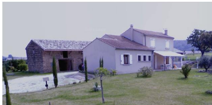
Exemple de restauration avec décroûtage de l'enduit et mise en place d'un enduit à pierre vue
