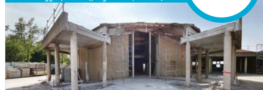
Suppression de 2 piliers de l'entrée principale.
