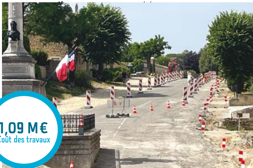
Terrassements pour la pose des bordures.
