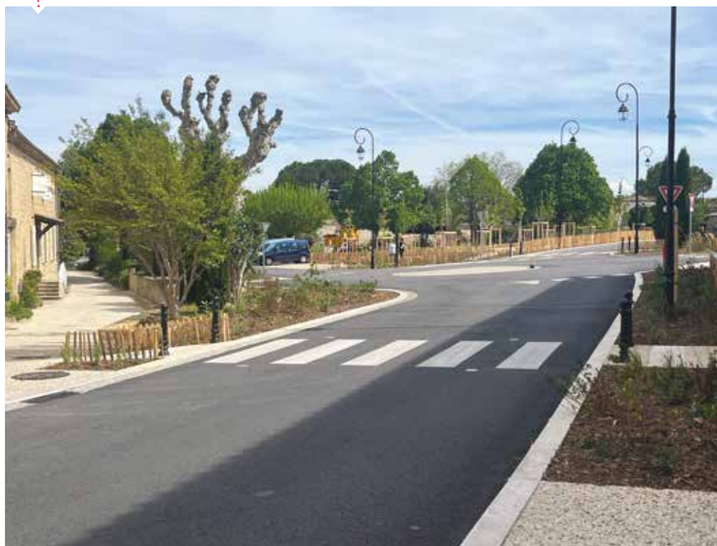
Un boulevard sécurisé.
